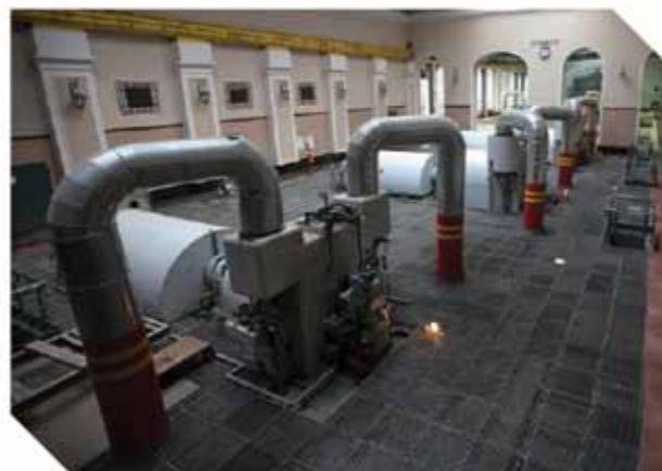
Применение настила на площадках обслуживания
