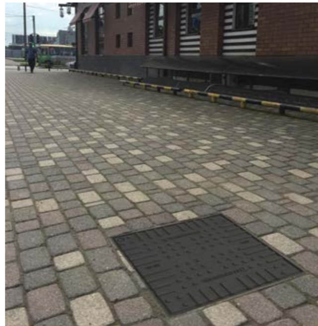
Установка люков на дождеприемники Стандартпарк
